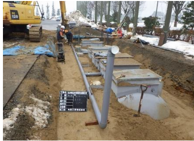
浄化槽設置工事
