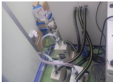
薬液配管工事
